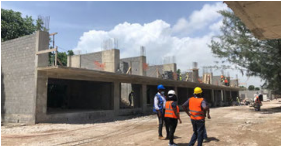
Les Cayes Works – June/2020
